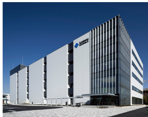
技術研究・創発棟 Cs-Lab+ (横須賀市・2025年完成)。住友重機械工業グループ全体の基盤要素技術開発などを行う一大拠点だ。
